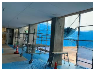
通路は天井も張替え
